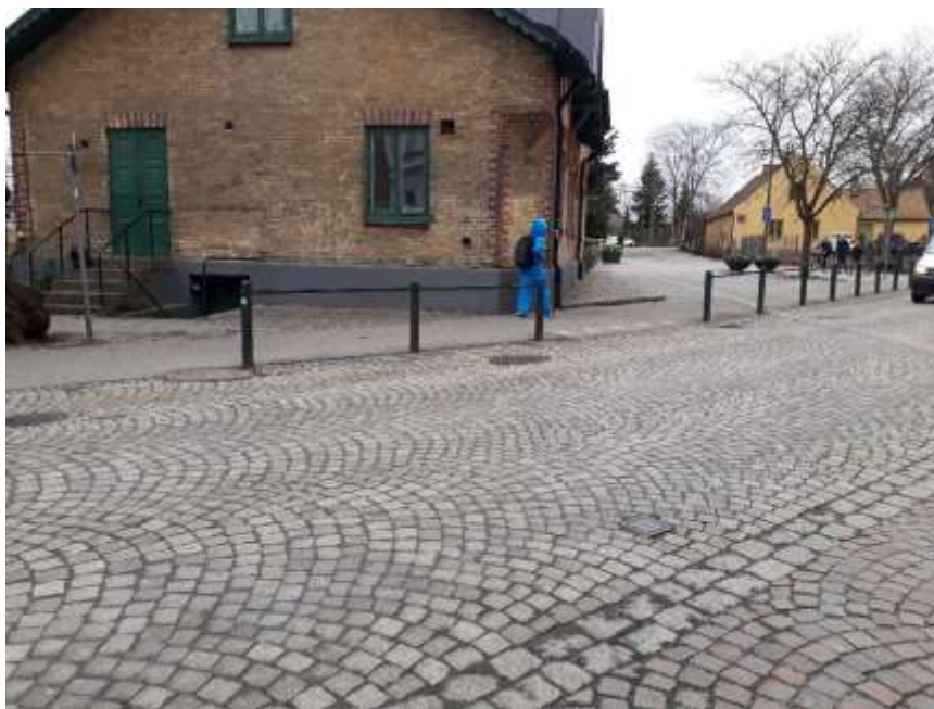
Figur 4: Gångbana försvinner och fotgängare tvingas ut i cykelbana samtidigt som det är dålig sikt.
